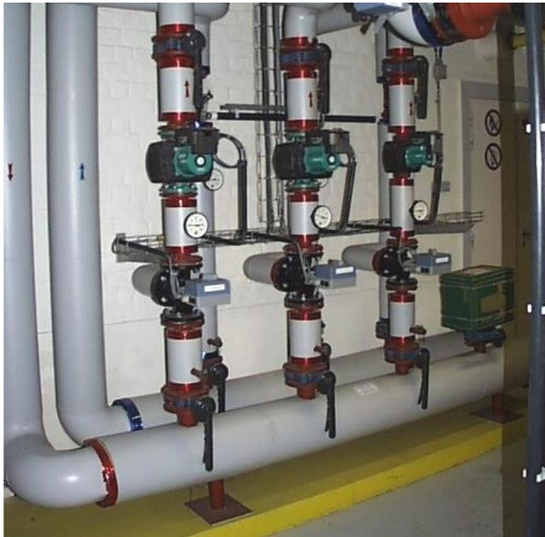
Exemple d'une boucle primaire à la base sur laquelle se raccordent les départs secondaires des différentes zones
