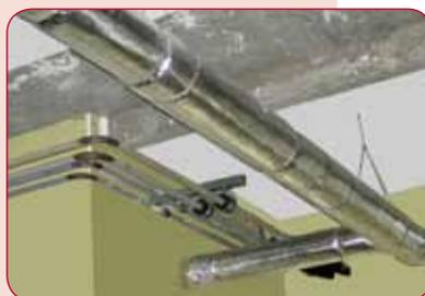
Lorsque de larges tuyauteries traversent des locaux chauffés, la puissance peut devenir tellement forte qu'elle entraîne une surchauffe inutile. Par exemple, un diamètre de 10 cm perdra plus de 150 W/m ! Dans ce cas, une isolation de la tuyauterie s'impose.
